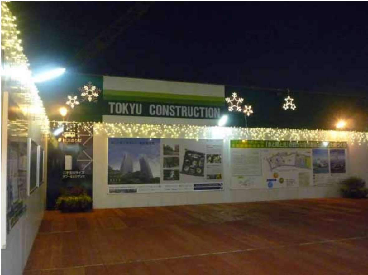
二子玉川駅東口仮設通路
