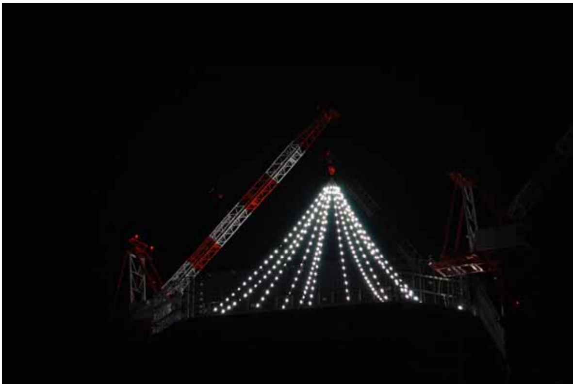
街区C棟12階付近上空
