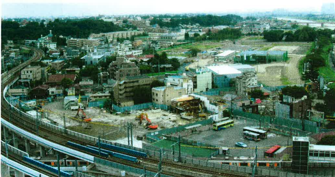
解体工事状況(玉川高島屋S・Cより撮影)
